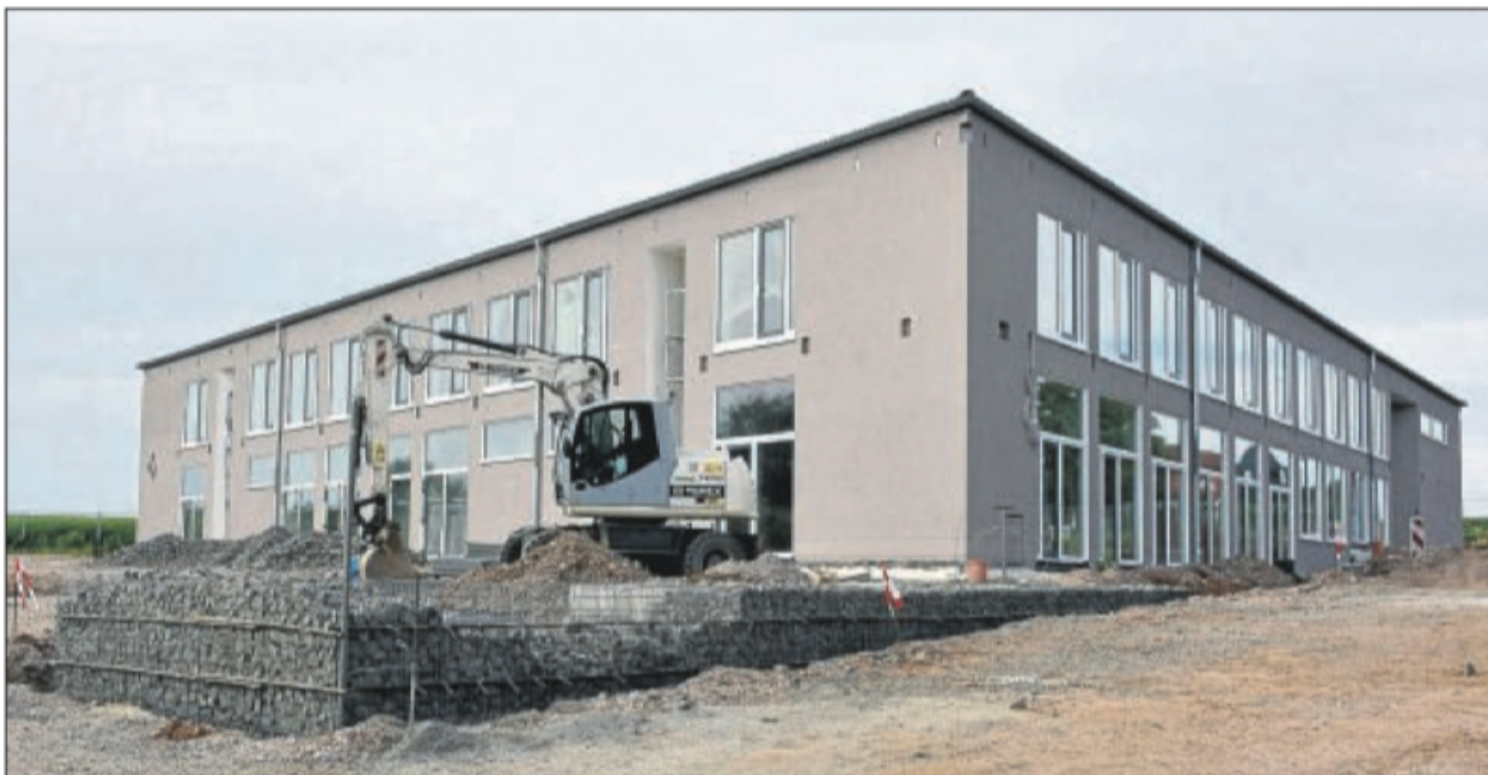
Die größte Investition des Landkreises: In Willingshausen entsteht eine neue Grundschule für Kinder aus allen Ortsteilen.
