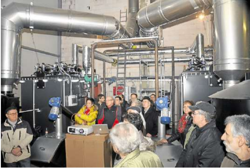
Im Alsfelder Stadtteil Lingelbach kommt die Wärme jetzt aus einer zentralen Heizanlage im Ort. Das Heizhaus im Konroder Weg präsentiert sich am Sonntag der Öffentlichkeit. Fotos: Krämer
