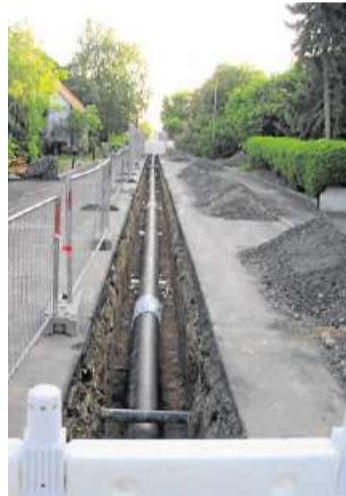
Leitungen verbinden Zentrale und bisher 100 Häuser im Ort.
