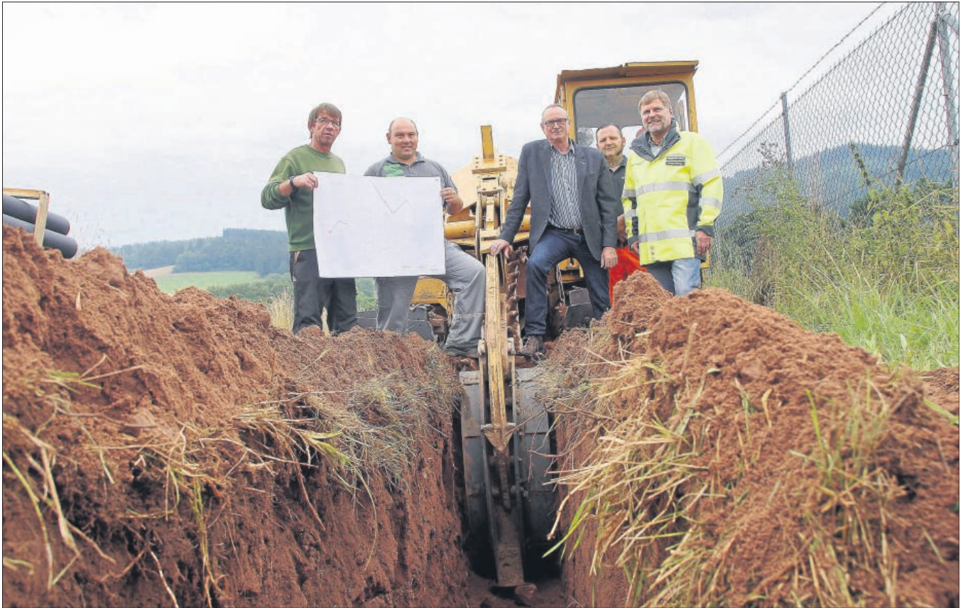
Mit Netzplan am Graben: (von links) Volker Dietz von der Baufirma Gringel, Jens Koberling (Regio-Meister Energienetz Mitte), Bürgermeister Volker Jaritz, Maschinist Christian Frühbote und EAM-Projektleiter Reinhold Steinberger begutachten bei Breitenbach die Arbeit der Spezialfräse. In dem entstandenen Graben werden in den kommenden Wochen Erdkabel verlegt.
